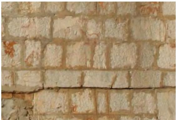
masivnijih klesanaca spojene zidnim plohama od grublje priklesanog kamena obrađenog zidarskim čekićem.
